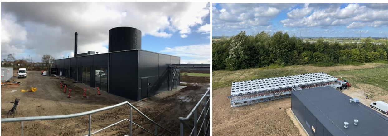
Billeder fra Bjæverskov Fjernvarme under opførelsen. T.v. ses værksbygningen og akkumulerings tanken. T.h. ses luftekølerne og noget af bygningen fra toppen af tanken.
